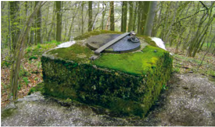
Bewuchs der Quellfassung
